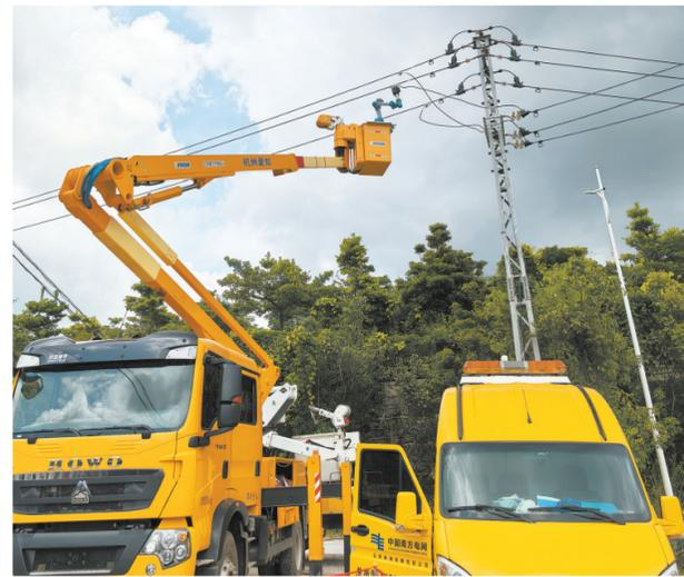
本报讯(通讯员 苟正涛 黄孝伟 文/图) 近日,南方电网云南普洱供电公司首次运用智能机器人带电搭接10千伏新建线路,这是配网带电作业智能机器人在普洱市的首次亮相,标志着我市电力配网不停电作业由传统人工作业向智能化作业转变。
